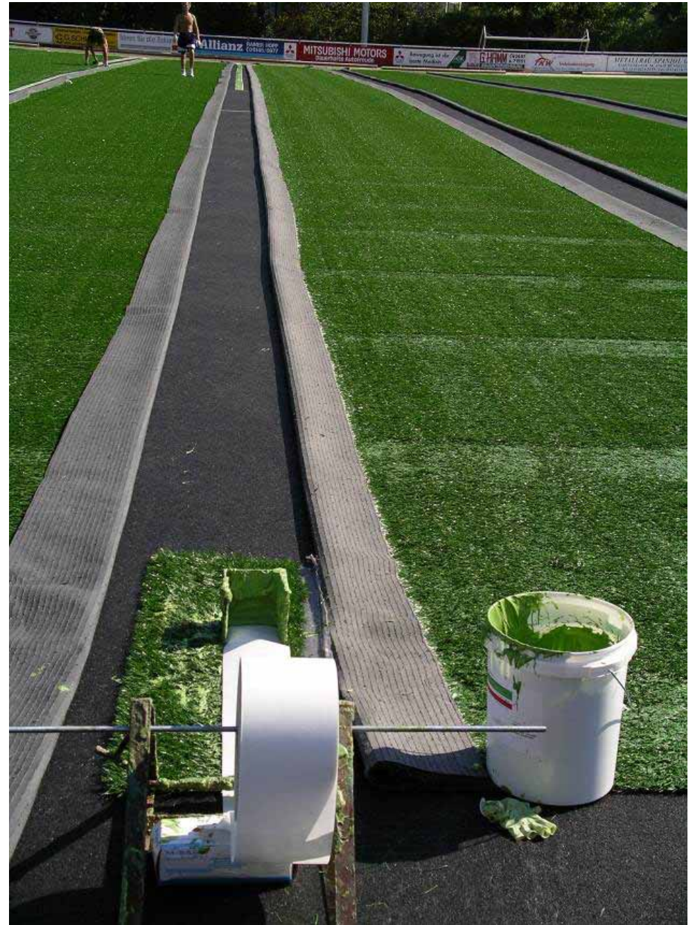
Umklappbarer Rücken eines polverfüllten KuRa
